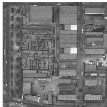
图 10 建筑物屋顶上的激光采样点和 CCD 图像的叠加
